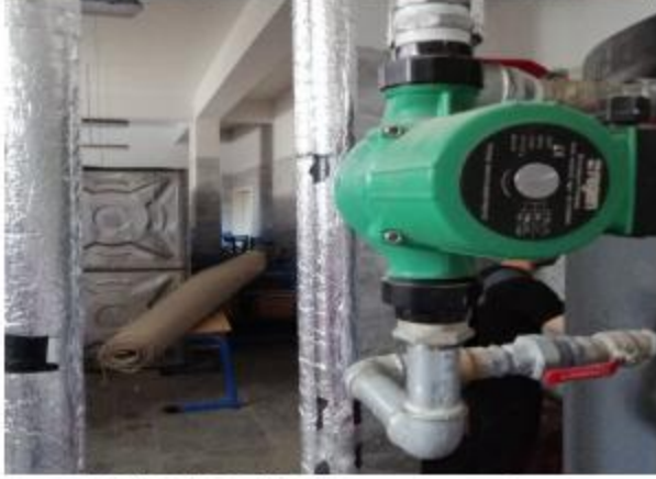
Şekil 5.1.3 Sirkülasyon Pompaları
