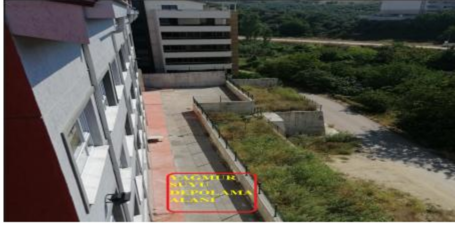
Şekil 8.3.1.1 Yağmur Suyu Depolama Alanı
